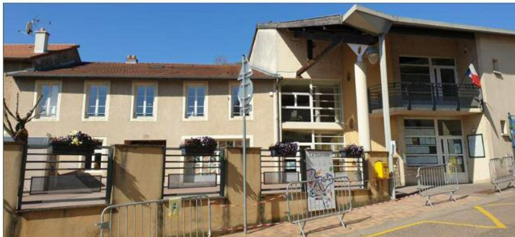
Le gros chantier de l'année se portera sur la rénovation des bâtiments de l'école et de la mairie. Photo RL
