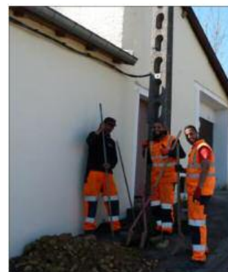
Les ouvriers ont creusé dans les cailloux pour installer un poteau.
