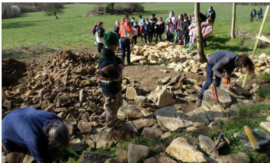
Les écoliers de Belleville sur le chantier du mur en pierre sèche.
