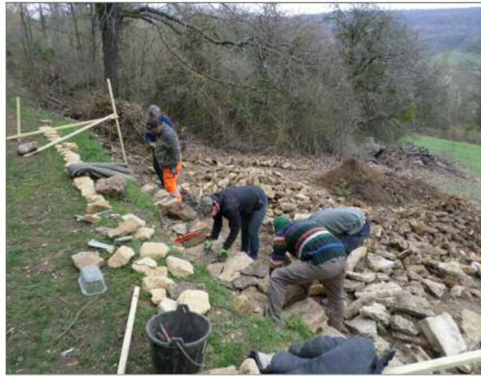
Le mur de soutènement du chemin de la Terrière en phase de restauration.
