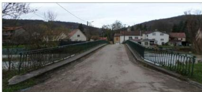
Des glissières en bois-métal seront installées sur le pont du Rupt-de-Mad afin de réduire la largeur de son passage à trois mètres.
