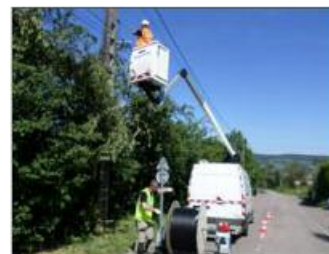
L'installation de la fibre est terminée.
