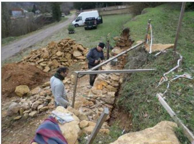
**La pierre de Jaumont étant utilisée, il faut rebâtir le mur plus en profondeur dans le talus.**
